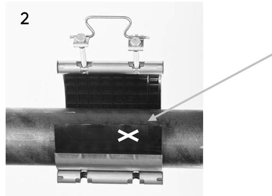
Reparaturschelle öffnen, über der Schadenstelle einmitten und 120° versetzt zum Verschluss positionieren.
