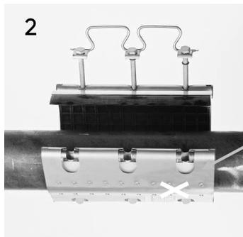
Reparaturschelle öffnen, über der Schadenstelle einmitten und 90° versetzt zum Verschluss positionieren. Dichtung muss flach auf dem Rohr liegen. **Achtung: Schrauben nie ganz herausdrehen**
