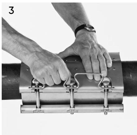
Verschluss einhaken. Schrauben abwechselnd und gleichmässig anziehen.
