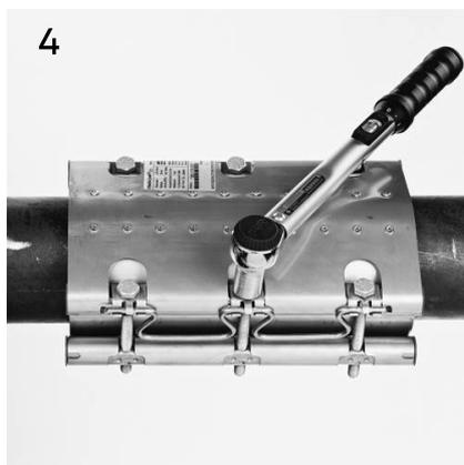
Mit Drehmomentschlüssel Schrauben wechselseitig festziehen. Auf der Kupplung angegebenes Drehmoment und Angaben beachten. Wiederholen des Anziehprozesses bis alle Schrauben innerhalb einer Vierteldrehung (90°) das angegebene Drehmoment erreichen.
